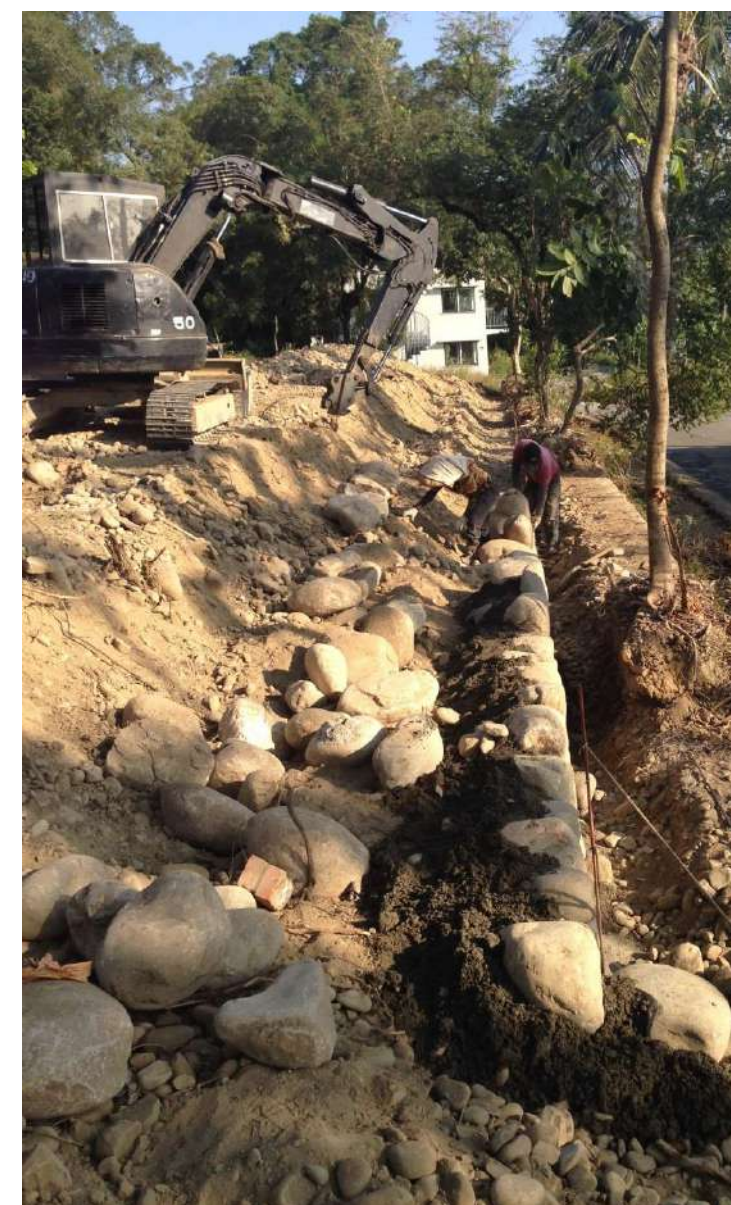
開發整地, 保留原地層原石, 鋪設堆砌擋土牆
