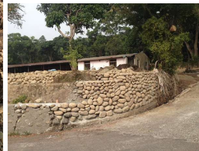
開發整地, 保留原地層原石, 鋪設堆砌擋土牆
