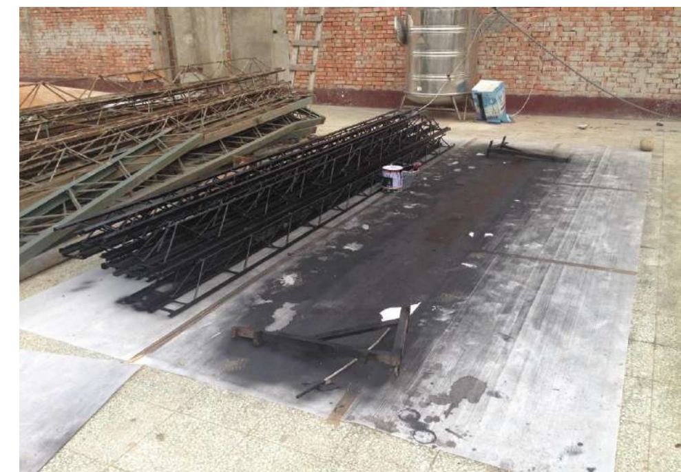
原屋頂結構桁架拆下做防鏽，塗裝
