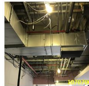
消防風管安裝施作
