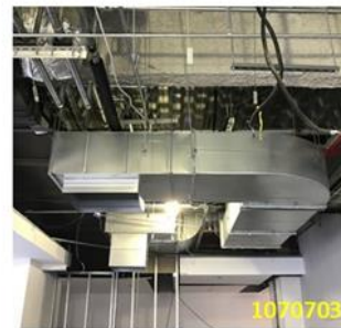
消防風管安裝施作
